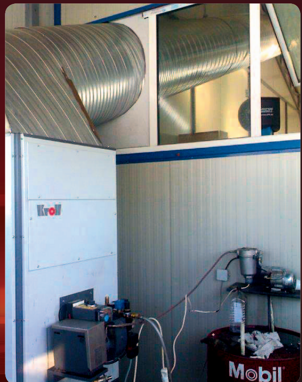
▲ Chauffage pour une salle d'exposition d'un garage Skoda en Roumanie.
