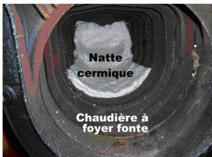
Placer la natte céramique au fond de la chambre de combustion de la chaudière fonte
