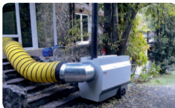
▲ Lieu d'installation: Centro de Eventos / Santiago de Chile
