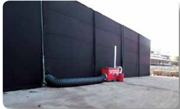
▲ Lieu d'installation: Evento Hipodromo / Santiago de Chile
