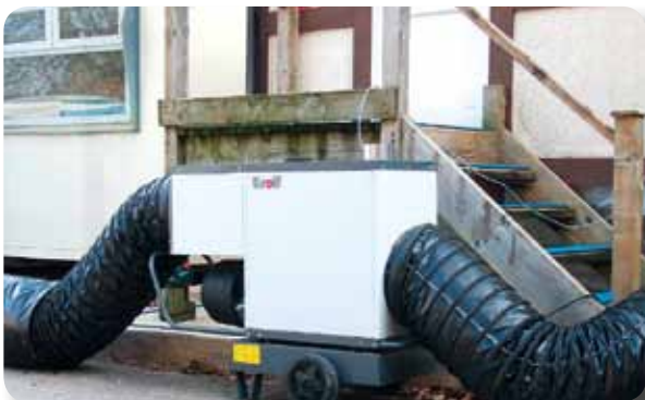
▲ Lieu d'installation: Ecole d'inondation à Farnham / Angleterre
