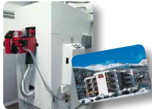
▲ Lieu d'installation: Hotel San Gian / St.Moritz (CH)
