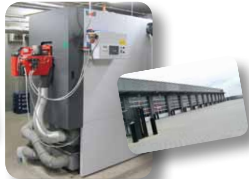
▲ Lieu d'installation: Garage VOLVO / Bettembuorg (LUX)
