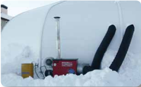
▲ Lieu d'installation: Valle Nevado / Santiago de Chile
