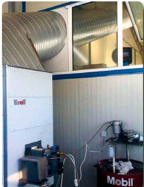
▲ Lieu d'installation: Hall d'exposition garage Škoda / Roumanie
