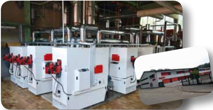
▲ Lieu d'installation: Usines "AGRIA" / Möckmühl
