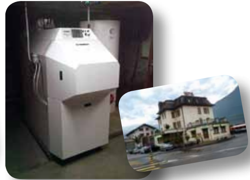
▲ Lieu d'installation: Hotel Martigny / Wallis (CH)
