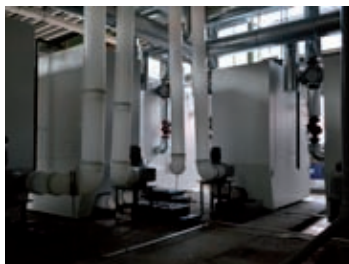
Les photos montrent bien la complexité de l'installation : A gauche le système d'évacuation ; au milieu : échangeur hydraulique ; à droite : le système d'évacuation du condensat.
