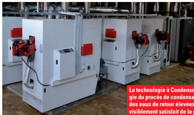
Les photos montrent bien la complexité de l'installation : A gauche le système d'évacuation ; au milieu : échangeur hydraulique ; à droite : le système d'évacuation du condensat.
