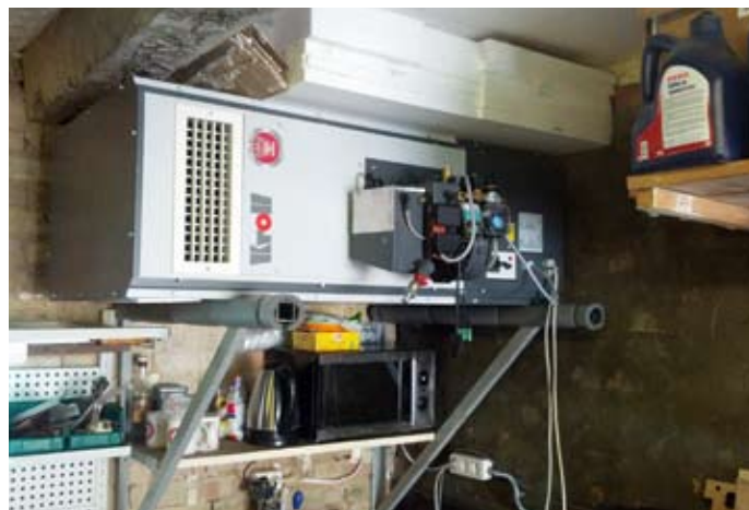
En bas : Montage non-habituel sous plafond pour gagner de place – générateur d'air chaud fixe 25S avec brûleur polycombustible KG/UB20P.
