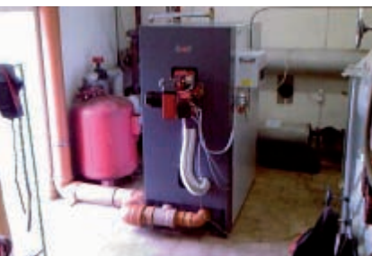
Producteur de chaleur fiable : Chaudière à Condensation Permanente BK250 de Kroll.
