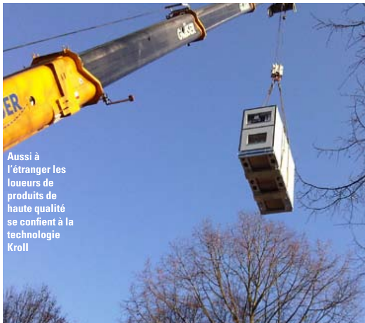
Les nouvelles Chaudières à Condensation Permanente mobiles BKM sont transportées par camion et mis en place par grue.
