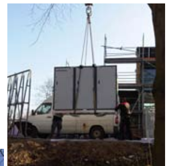
Les nouvelles Chaudières à Condensation Permanente mobiles BKM sont transportées par camion et mis en place par grue.
