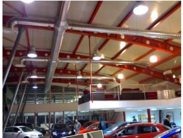
Dans ce garage Skoda avec salle d'exposition et de service, un volume de 10 000m<sup>3</sup> sont chauffés par un générateur d'air chaud avec brûleur HVP de Kroll.
